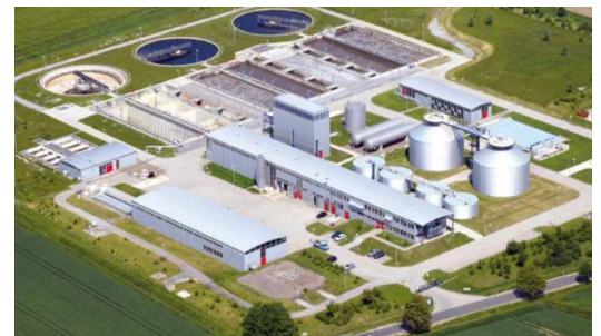
Toàn cảnh nhà máy Salzgitter từ trên không
