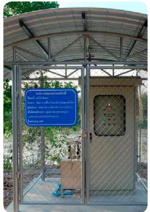
Bên trên: Là một trong 16 trạm quan trắc nước sông mới được lắp đặt ở khu vực đô thị của Bangkok. Nó được trang bị một căn nhà để đảm bảo các thiết bị đo lường không bị phá hoại và trộm cắp.
