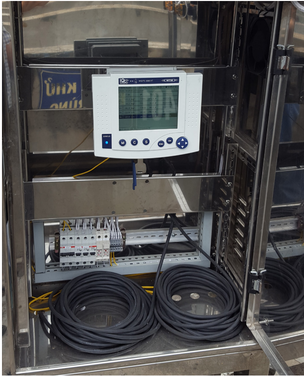
Hình 7 – Hình ảnh (tại Lê Minh Xuân) của tủ sử dụng với bộ điều khiển đã cài đặt để lưu trữ dữ liệu trực tuyến.
